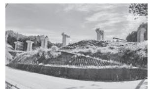
写真① 付替県道10号橋脚
