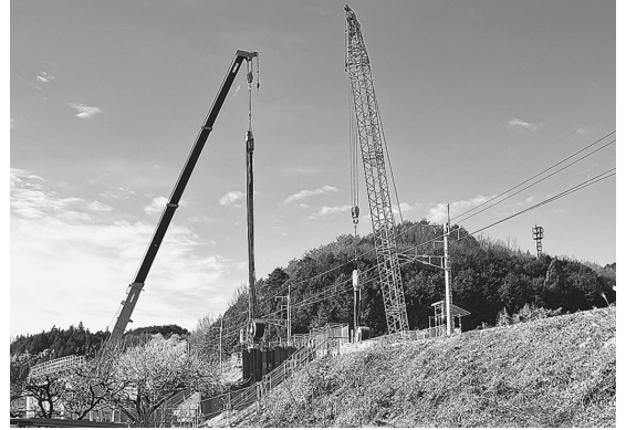
リニア関連工事現場 座光寺上郷道路飯田線アンダーパス工事
