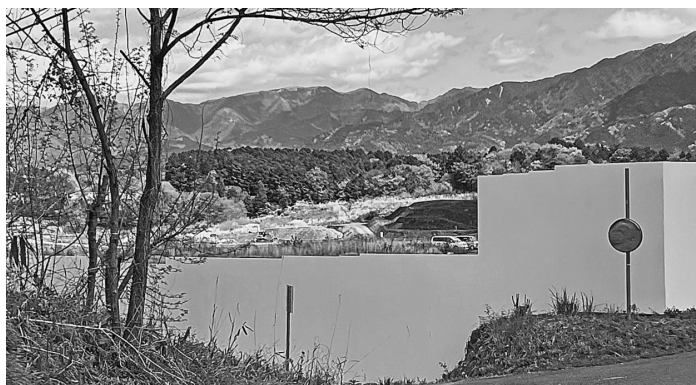
車両基地工事現場
