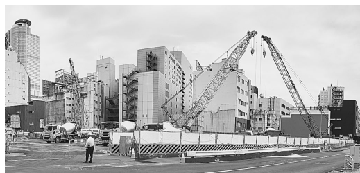
筈瀬川筋の工事状況（同②）
