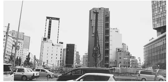
ビルが解体され工事ヤードになった区画 (下概略図④)
