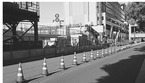
品川駅前の非開削工区 品川駅の3工区
