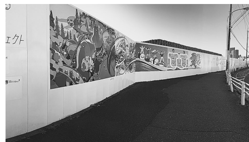
神奈川県駅の仮囲いと土嚢の山
