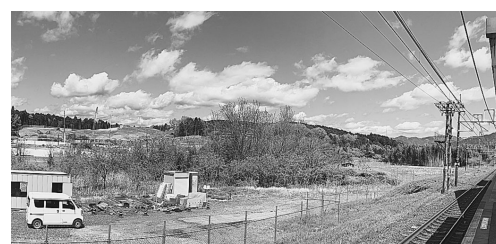
JR美乃坂本駅から見る岐阜県駅工事現場
