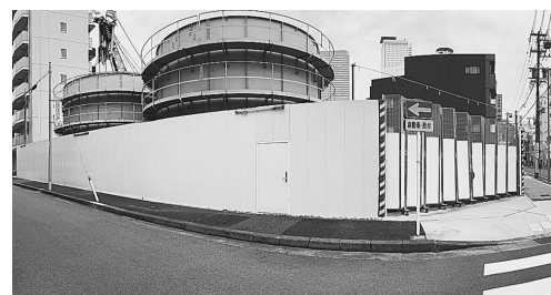
名古屋市中村区 仮囲いと工事プラント
