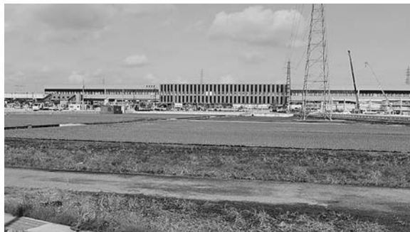
建設中の北陸線幹線新高岡駅(平成26年)
