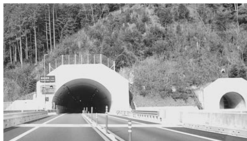
東栄IC・浦川IC間の浦川奈根トンネル
