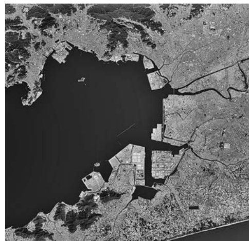
三河港全貌 (航空写真)
