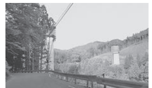
写真② 付替国道257号橋脚
